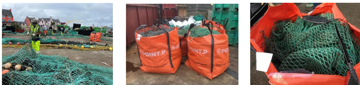
Figure 38 : Photos d'une opération de démontage de chaluts usagés pour recyclage des nappes en PEHD (Source : rapport FILIPECH – port du Guilvinec)
